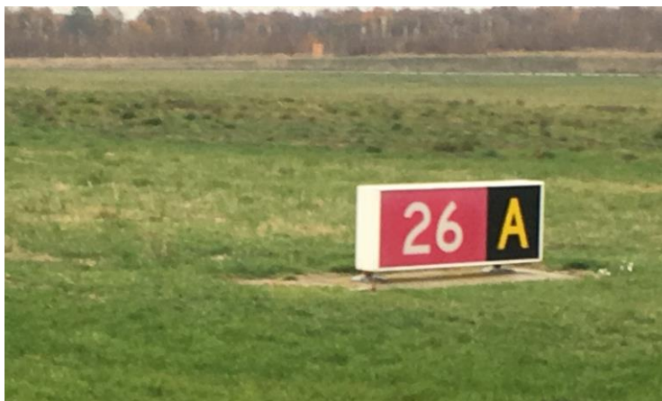
Rollhaltbeschilderung mit Pistenbezeichnung und Standortangabe. Bedeutung hier: Standort Rollbahn A am Rollhalt der Piste 26.
