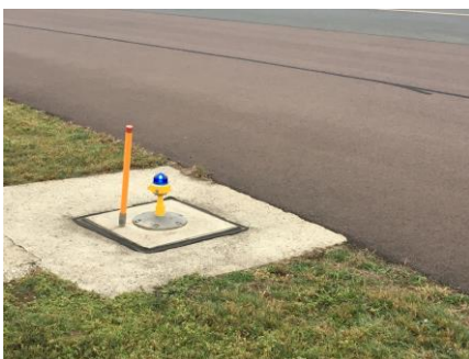
Rollbahnrandfeuer in blau (inkl. Schneemarker)
