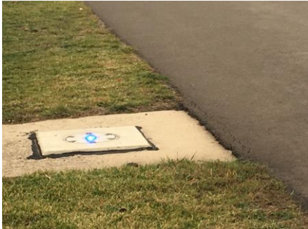
Rollbahnrandfeuer in blau (Unterflurvariante)
